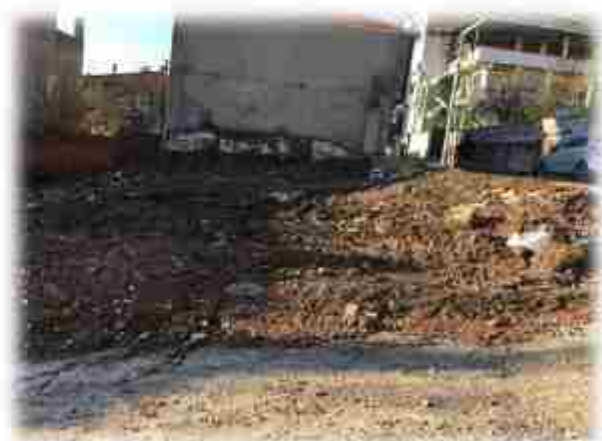
6306 Sayılı Kanuna istinaden yıkılan yapı
