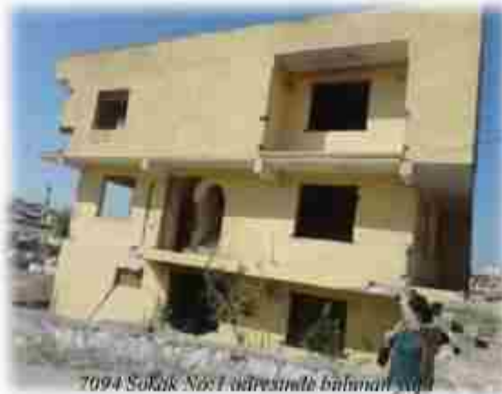
7094 Sokak No:1 adresinde bulunan yapı
