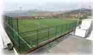
Doğançay Spor Tesisi
