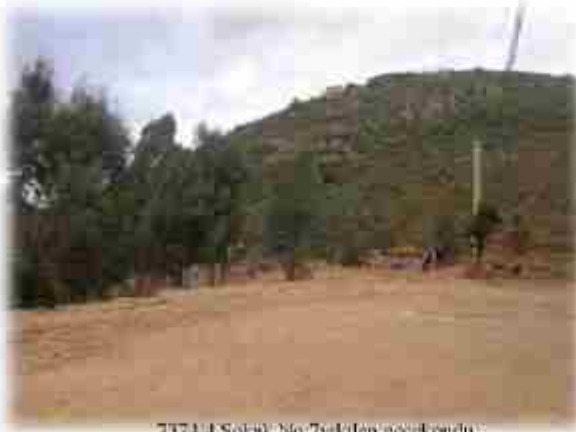
7374/4 Sokak No:7 yıkılan evcekonda
