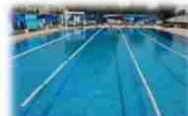
Bayraklı Yüzme Havuzu
