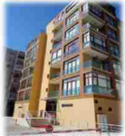
Apartmanda yapılan balkon kapatmaları
